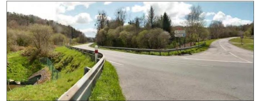
RN 164 au niveau de la vallée du ruisseau de Poulance
